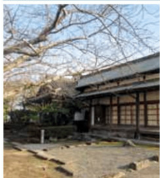
佐伯城三の丸御殿の玄関・広間部分を解体し、船頭町に移築。
