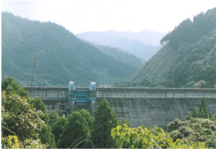
ダム下流からダム正面を望む
