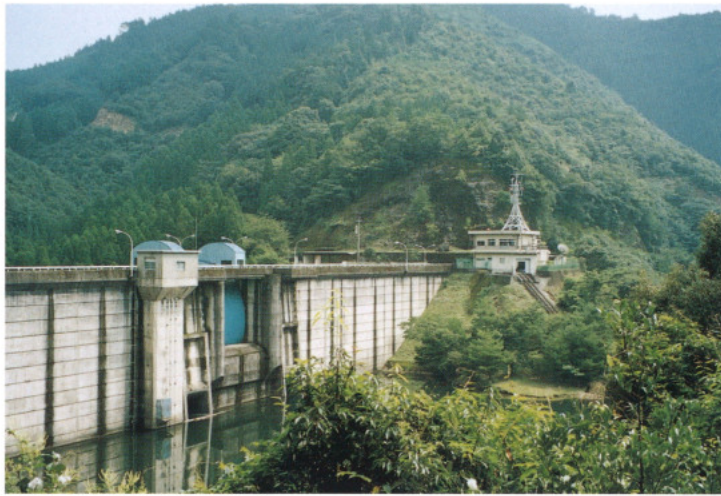
上流左岸からダムを望む
